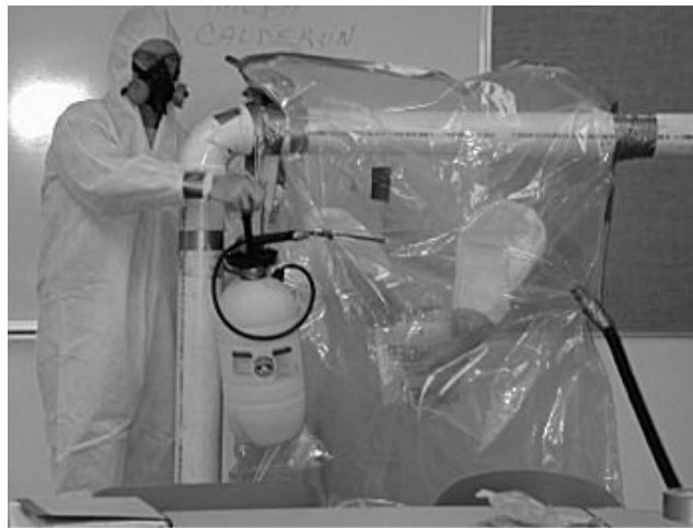
〈그림 1.5-1〉 글로브백 설치 모습
