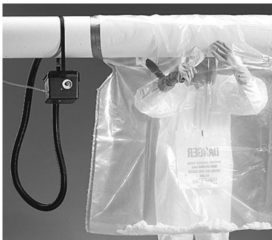
〈그림 1.5-3〉 글로브백안에 석면을 제거하는 모습
