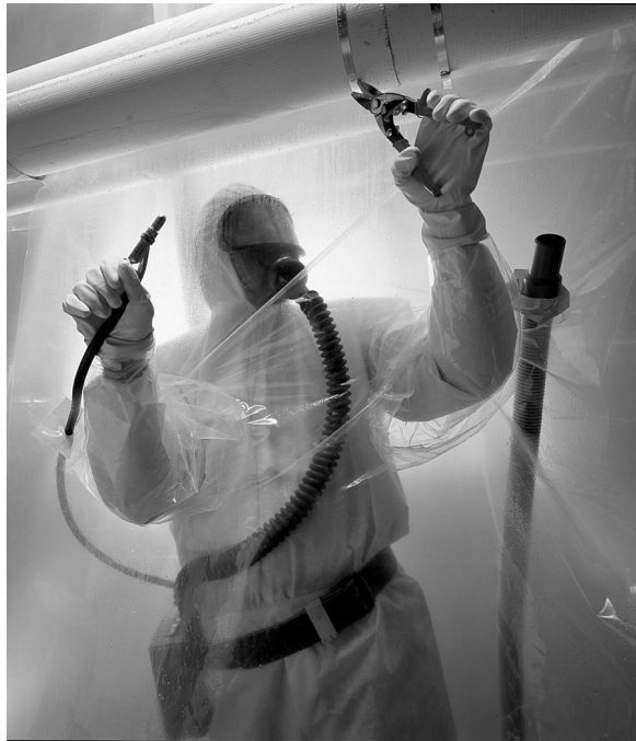
〈그림 1.5-2〉 파이프에 있는 금속 또는 철사를 제거하는 모습
